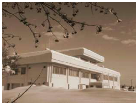
北空知広域水道企業団事務局と北空知広域浄水場
